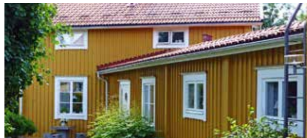
En lång låg tillbyggnad i vinkel som genom sin form, färg och placering låter huvudbyggnaden tydligt dominera.
